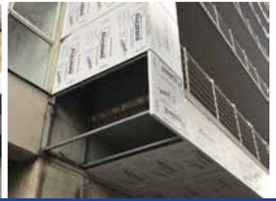
El Panel de Aluminio Compuesto es el nombre genérico con que se define al ensamble formado por dos hojas de aluminio con un núcleo termoplástico para formar un material compuesto con espesores de 3mm, 4mm y sobre pedido de 6mm, de gran planicidad con una densidad 1.25 muy baja en comparación a densidad 2.7 del aluminio sólido ó 7.85 del acero.
